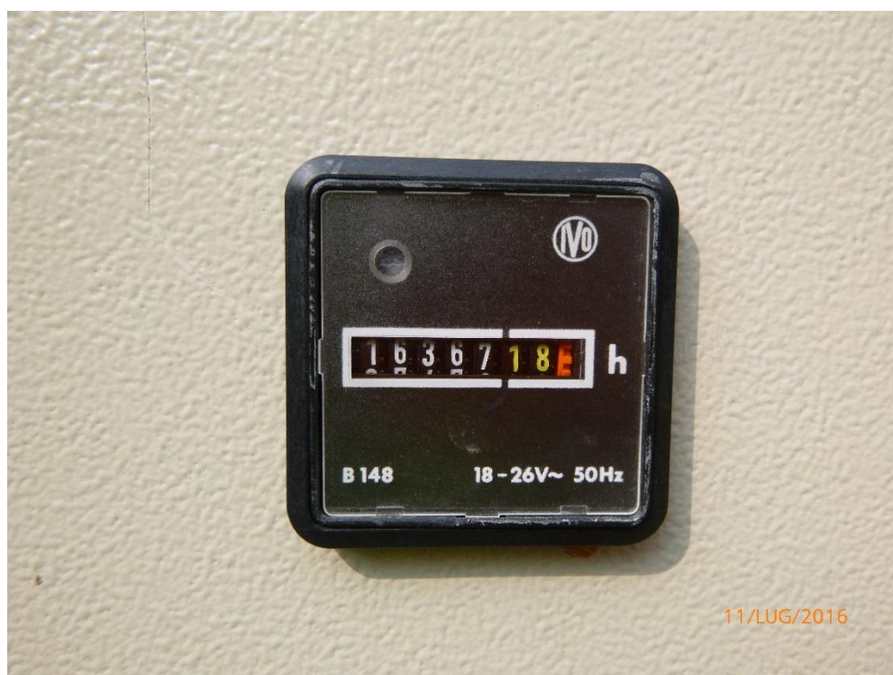
Foto 1: contatore pompa Lago di Cava
